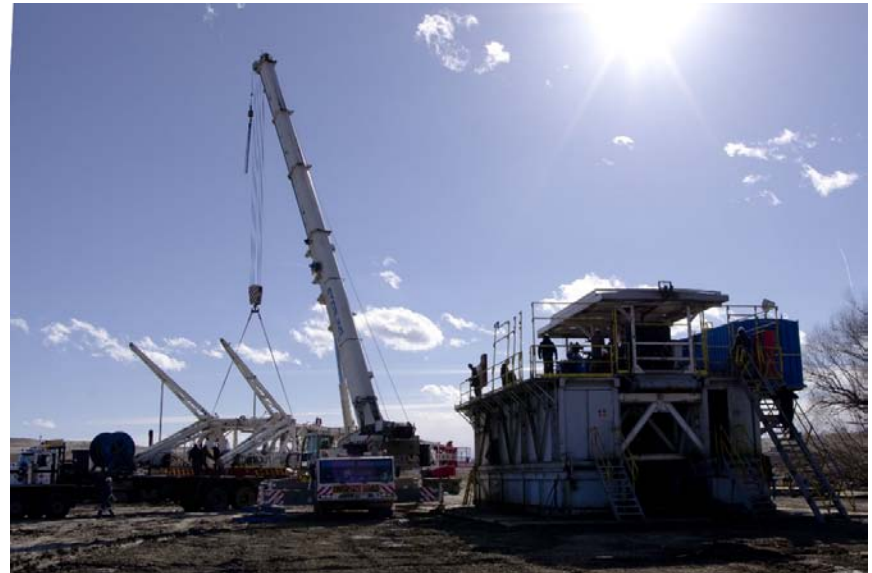
Aufbau des Bohrturms für HZ-Bohrung
